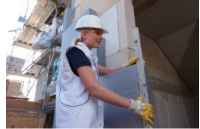
Wärmedämmung an einer Fassade Detailansicht
